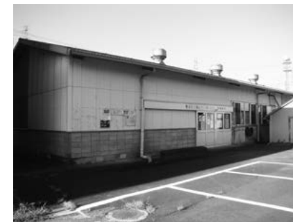
作物実習室（平成27年度屋根工事）
